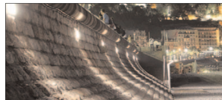
Aménagement Plage de Carras.
