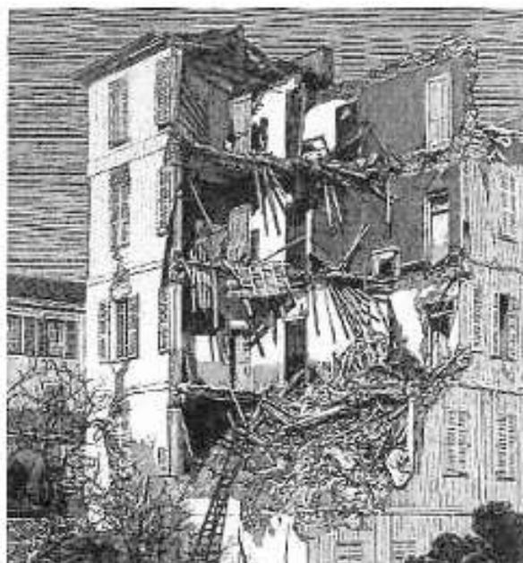
*Figure 12 : Les effets du séisme de 1887 sur une construction du littoral méditerranéen*
