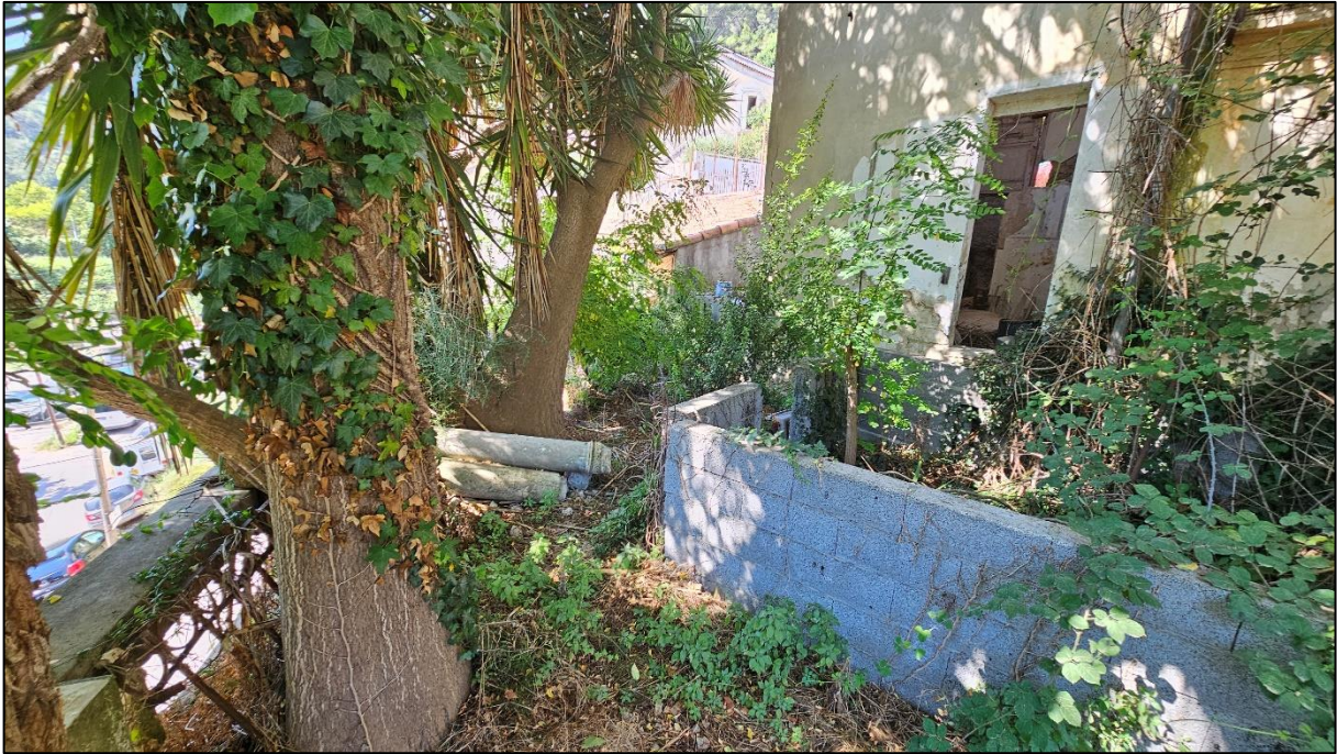
Implantation des Arbres en tête du mur de soutènement – Source : Geo-GC
