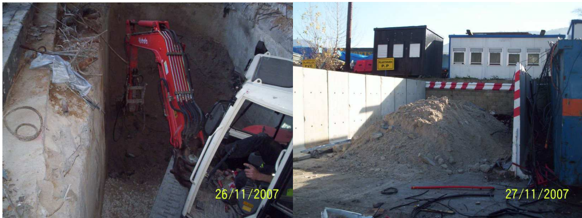
Figure n°6 : Enlèvement des remblais pollués sous l'emprise des berceaux et stockage temporaire des terres polluées avant mise en place du polyane.
