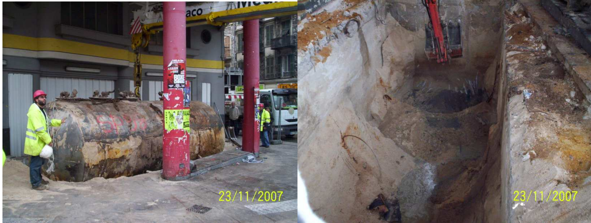
Figure n°5 : Enlèvement du réservoir et vue sur la fosse maçonnée et les sables.
