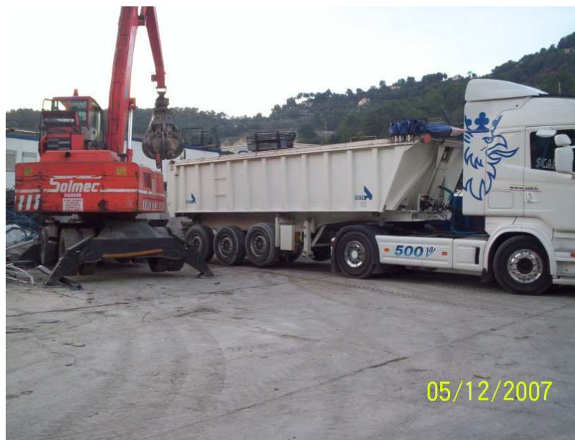
Figure n°14 : Chargement des terres polluées.
