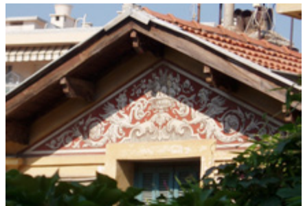
[7] Les décors de sgraffite sur les frises en dessous de toit sont caractéristiques des maisonnettes niçoises de la fin XIX e -début XX e siècles © Photographie Ville de Nice.
