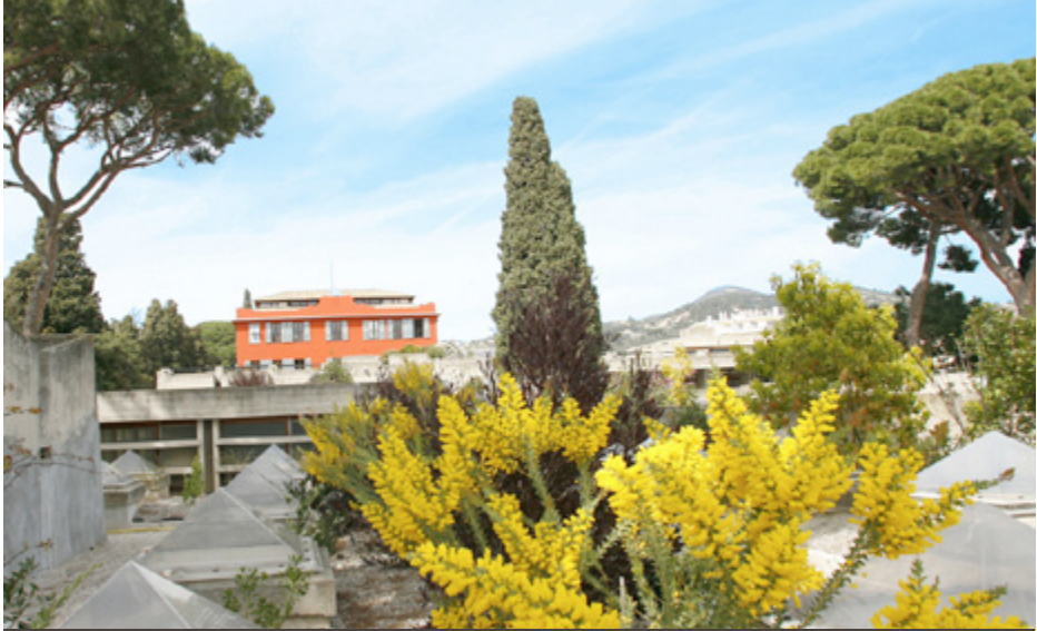
[9] Les toits terrasses de l'École nationale d'Art décoratif de la Villa Arson. © Photographie Ville de Nice.
